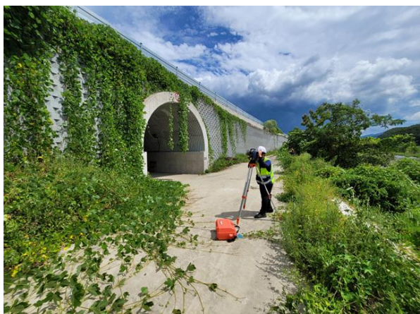
광파기를 이용한 측량 작업
