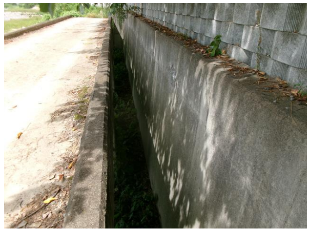
하부 배수로 전경
