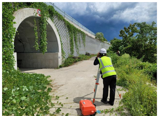
광파기를 이용한 경사도 측정
