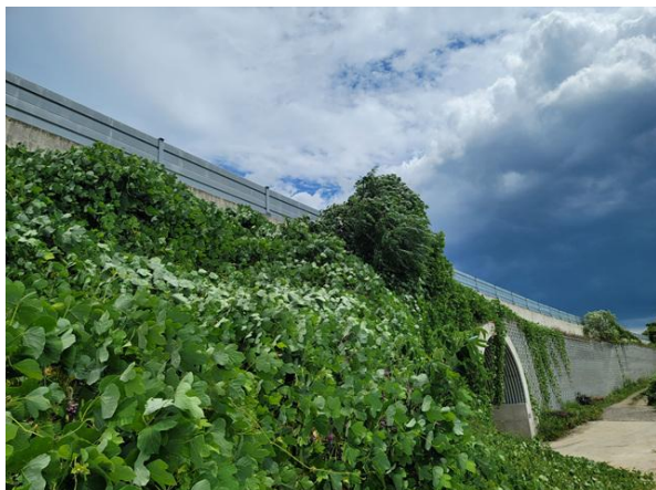
주변영향인자(성토부, 상부 본선) 상태현황
