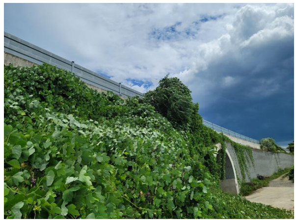
상부 성토부 전경
